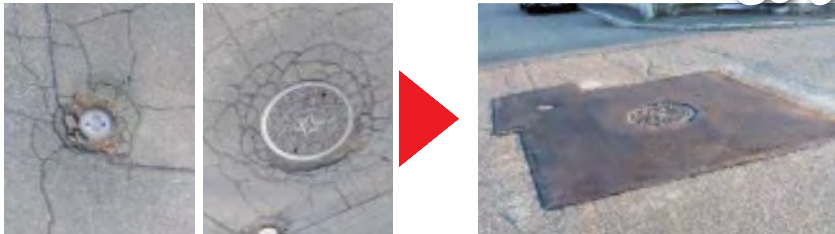
アスファルトが剥がれているところを補修
