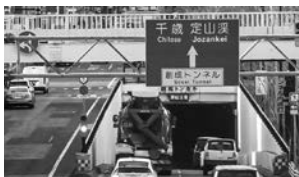
創成トンネル
